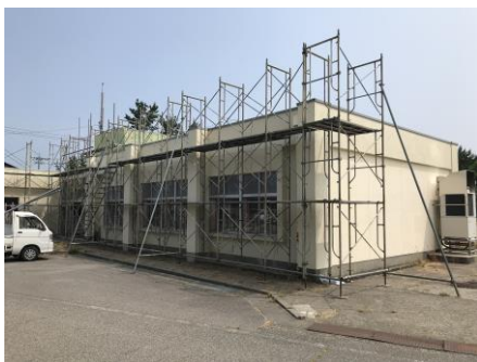
山口分場 工事中の外観
