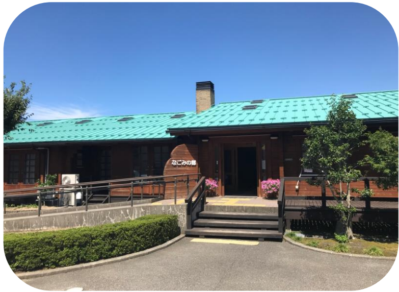
屋根全面葺き替え改修を行い きれいになったなごみの郷
